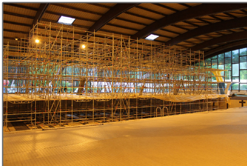
Vue du chantier en cours
