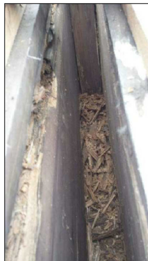
Vues intérieures d'une des poutres abîmées
