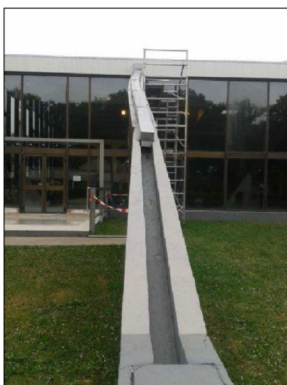
Vue extérieure d'une des poutres «habillées» par un acier galvanisé
